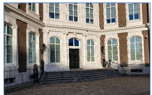
Gebouw Raad van State
